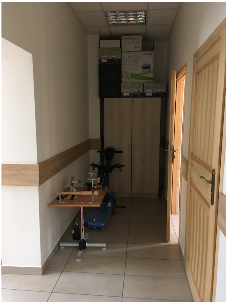
Fot. 3. Strefa komunikacji – ściany zabezpieczone listwami. Lepszą wersją jest montaż pochwytyków.
